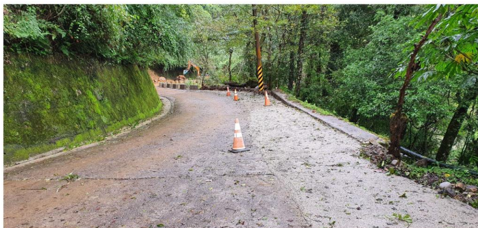
林道施工(新竹林管處提供)
